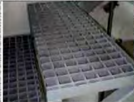
ชั้นบันไดตะแกรง FRP กรอบเหล็ก
